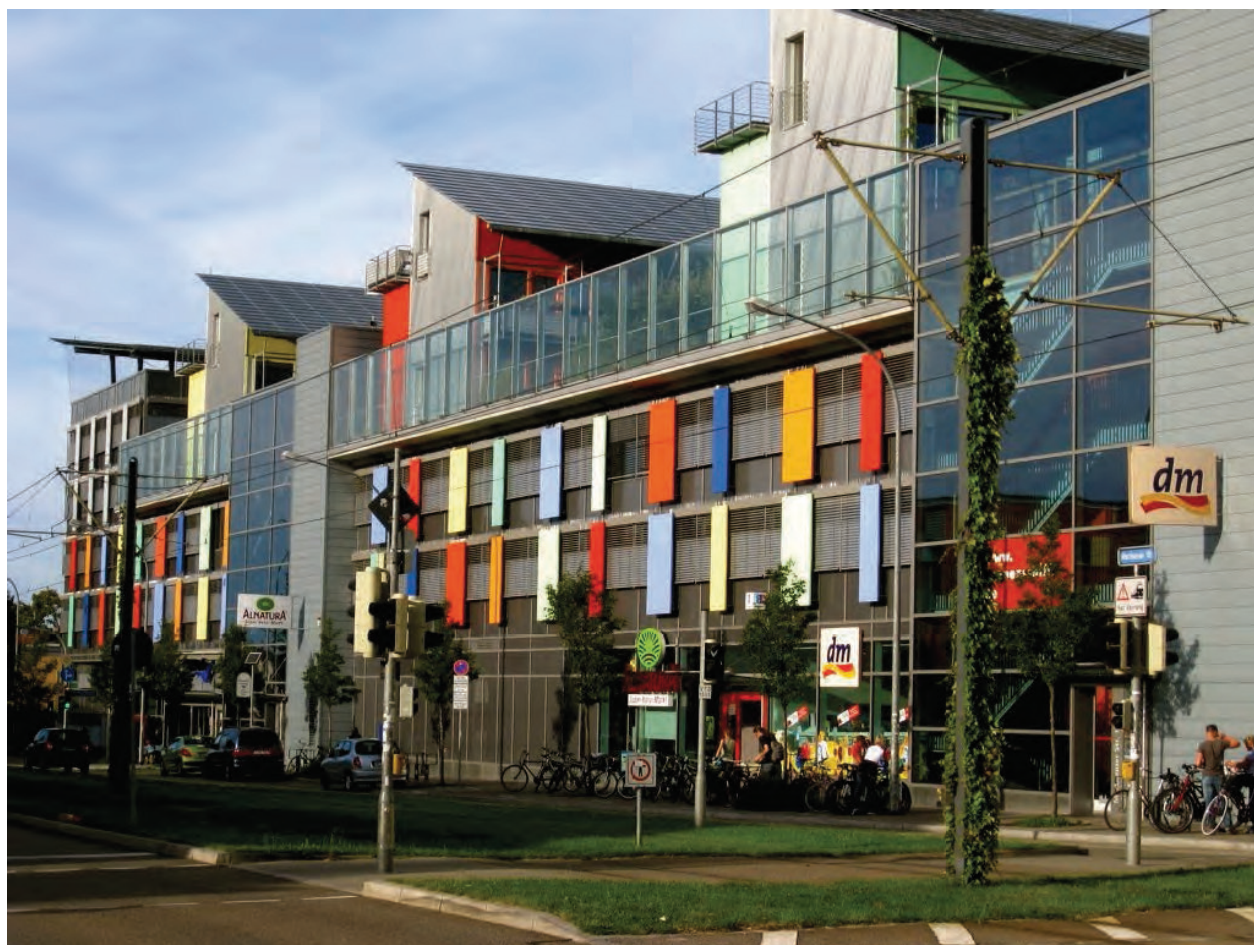
Figura 14 Foto de Das Sonnenschiff (el Barco Solar) Vauban (Alemania) por Jute Marketing/CC BY-NC-ND 2.0. Das Sonnenschiff es una pequeña comunidad que utiliza en su totalidad energía solar, situada en el “ecobarrio” de Vauban, una pequeña ciudad de Alemania donde existen 92 casas pasivas y 10 casas “EnergyPlus” [63].
